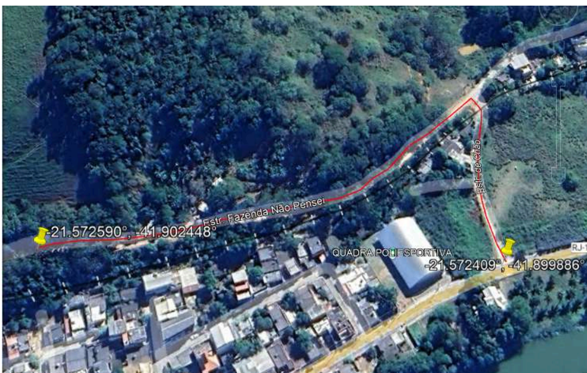
Situação da Estrada de Chão/parte da Estrada da fazenda Não Pensei
