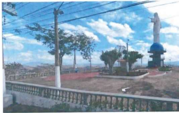
Imagem 1 – Praça Cristo canteiros e pavimentação existentes.
