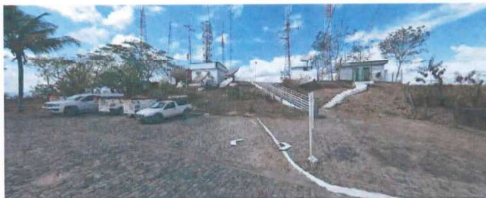
Imagem 3 – Praça Cristo canteiros e pavimentação existentes.
